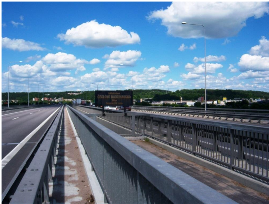
Kauno technikos kolegijos absolvento Česlovo Radzinausko vardo tiltas per Nemuną Kaune .
